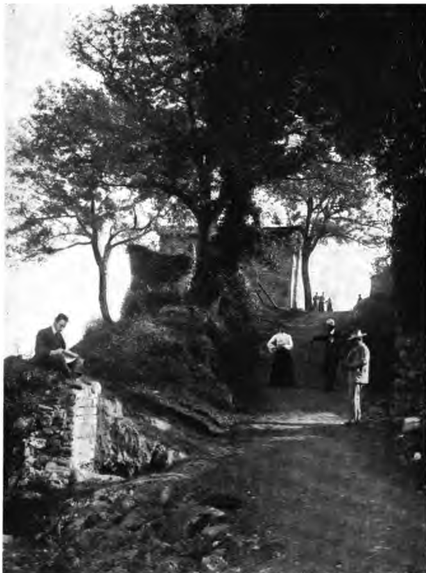
S. MARTINO IN PEDRIOLO — RUDERI DEL CASTELLO DI FIAGNANO (INGRESSO).
